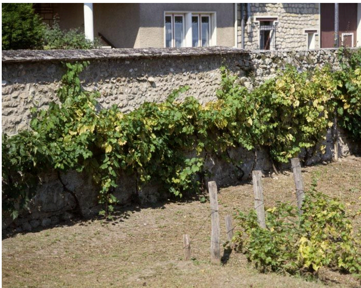
Les murs de clôture du jardin utilisés comme murs à chasselas : détail.
