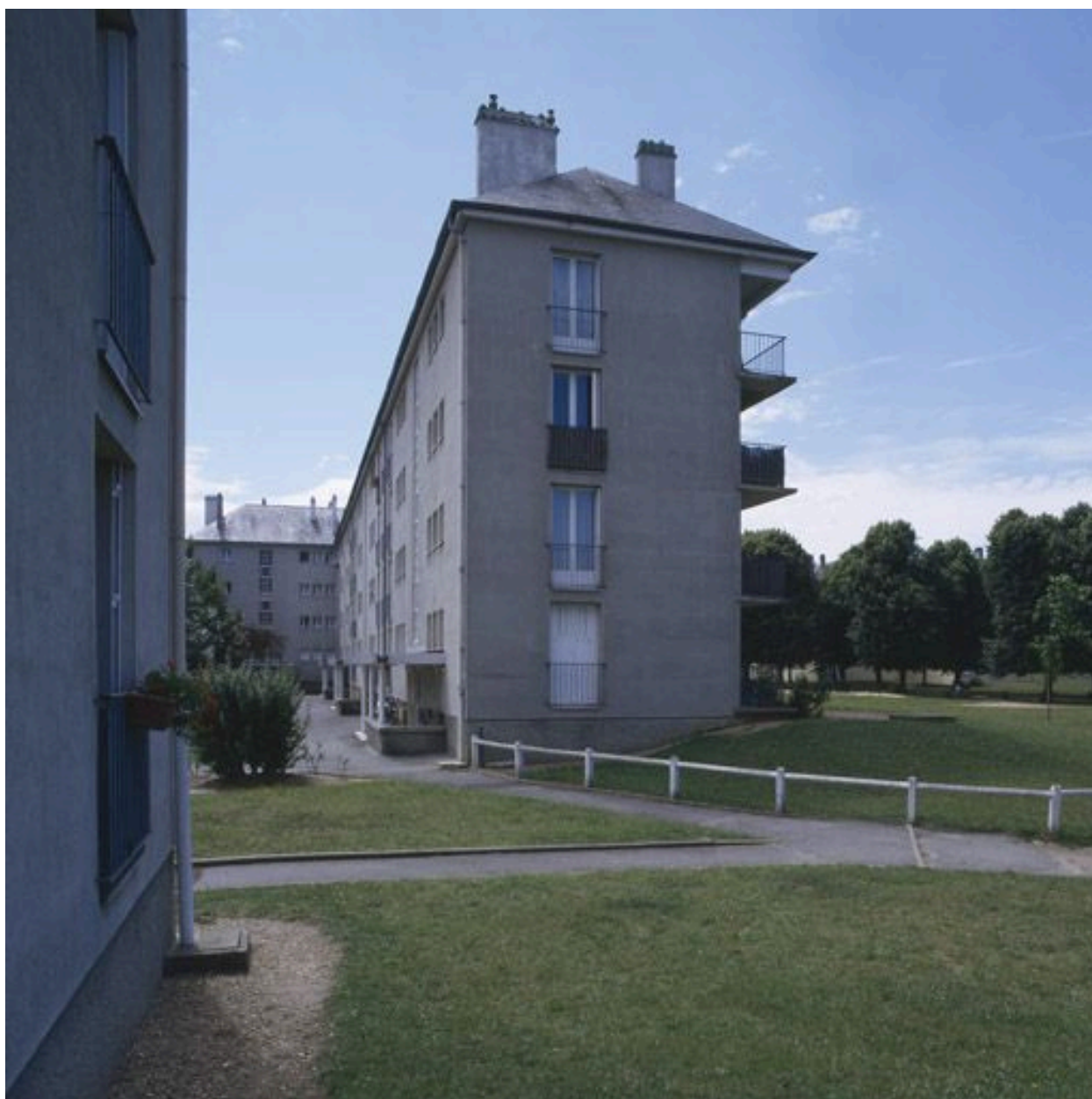
Vue partielle des immeubles situés au 196 et 201, boulevard Henri-Barbusse.
