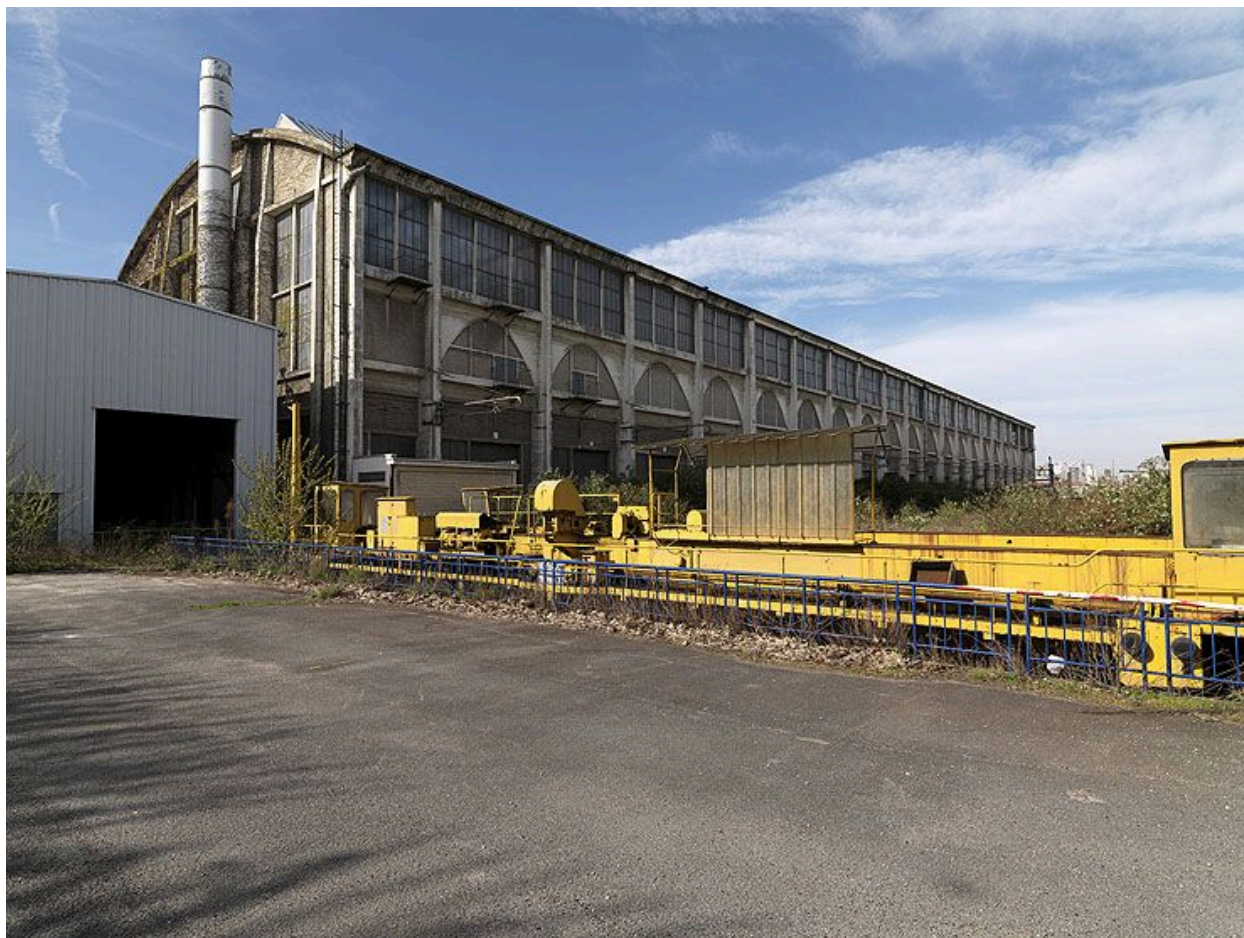
Vitry-sur-Seine. Vue d'ensemble des halles de la gare des Ardoines, abritant les ateliers de réparation de la SNCF.
