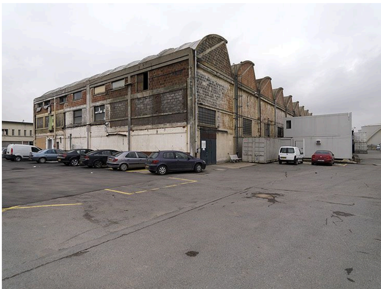
Villeneuve-le-Roi, usine de construction navale dite Chantiers de la Haute Seine, rue des Voeux-de-Saint-Georges. Extérieur des ateliers.
