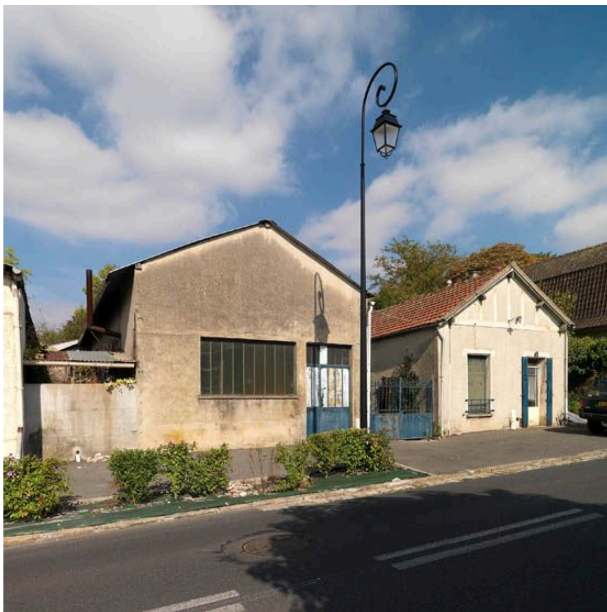
Vue d'ensemble de l'usine de petite métallurgie Durand.
