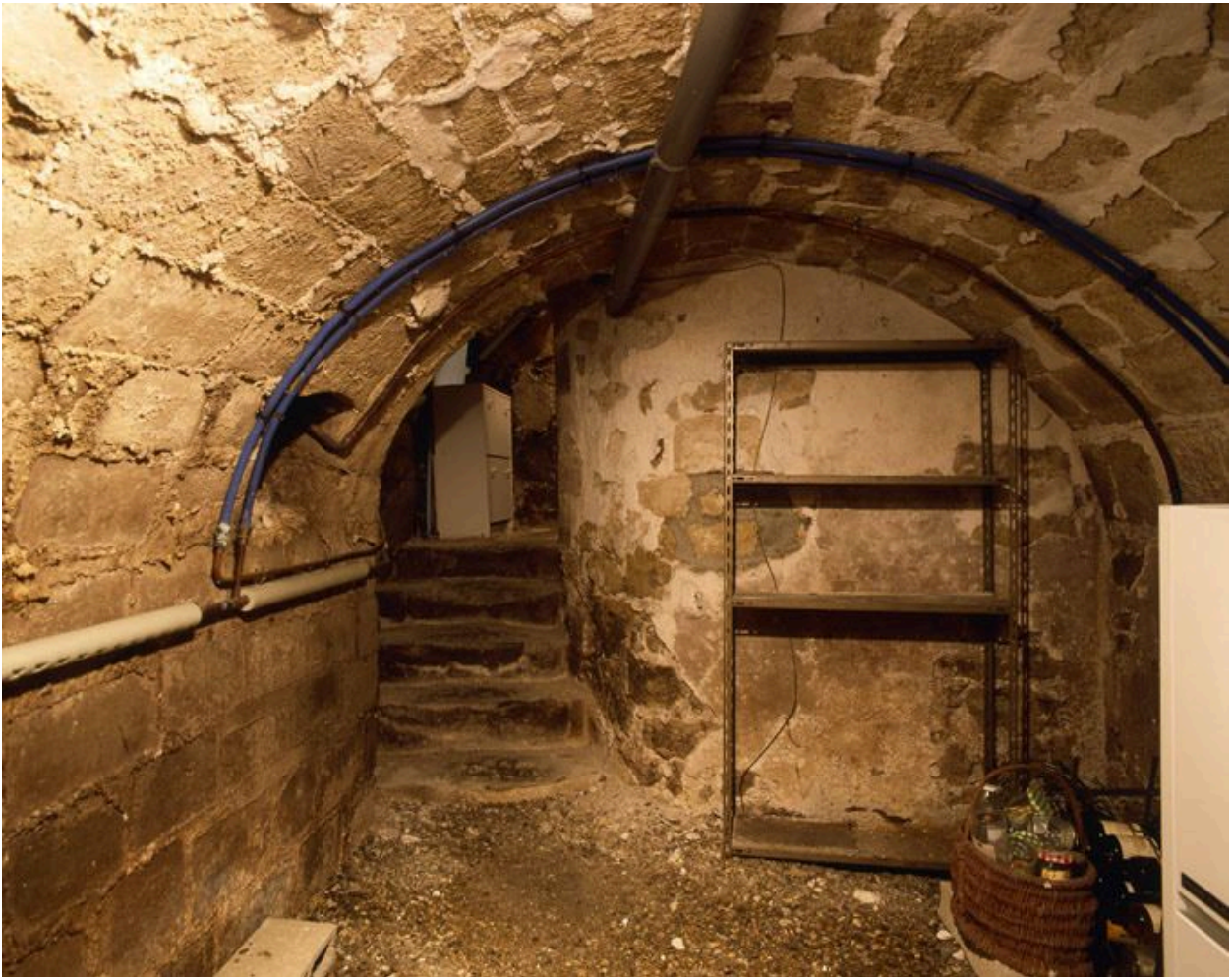
Le cellier qui se trouve sous l'ancien logement de l'instituteur. Vue d'ensemble.
