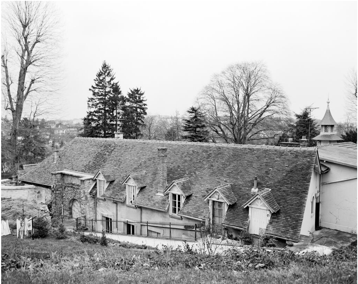
Communs, vue des toits.
