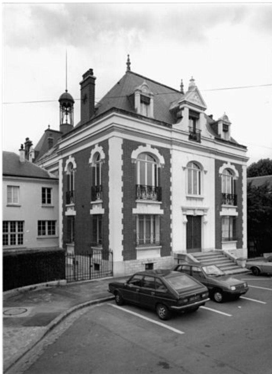
Façade postérieure du corps central.
