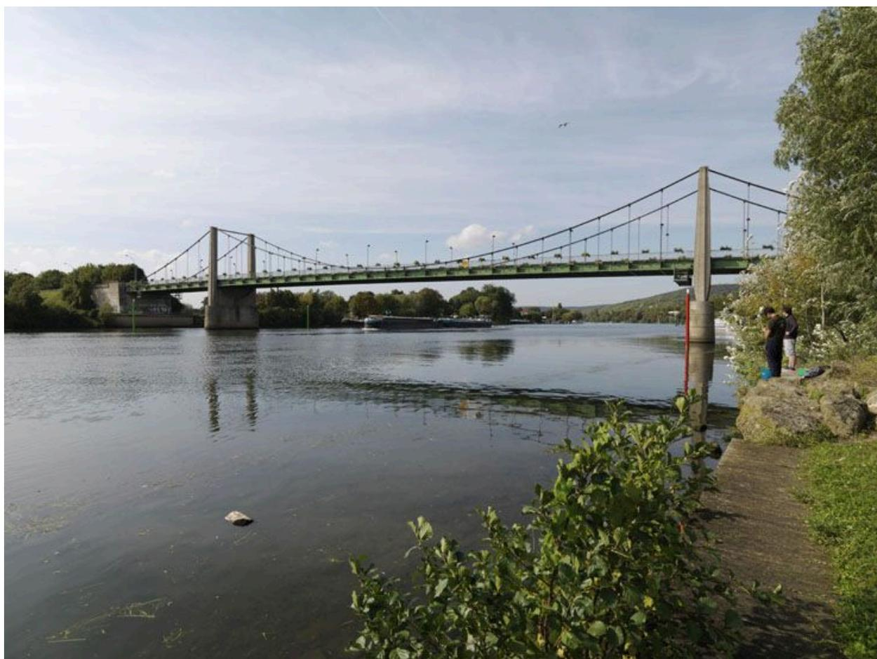
Vue générale de l'ouvrage depuis les quais vers l'aval. On aperçoit sur l'autre rive la culée en béton à laquelle les câbles de retenue sont reliés.
