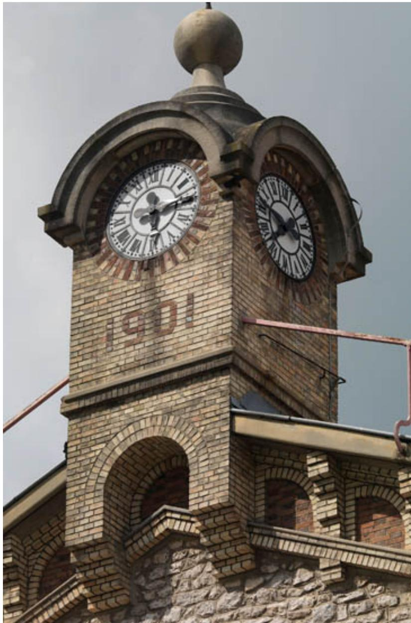
Clocheton en brique surmontant la nef centrale. Surmonté d'un dôme en ciment moulé et portant une horloge. La date de 1901 en briques rouges.
