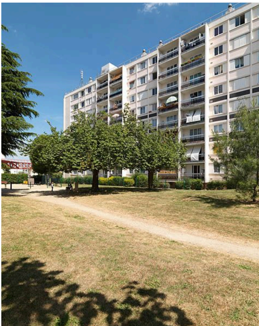
Cité dite Résidence Saint-Hubert. Façade principale rénovée d'une barre R+7 et travail de résidentialisation. Travées de fenêtres de séjours et de chambres.
