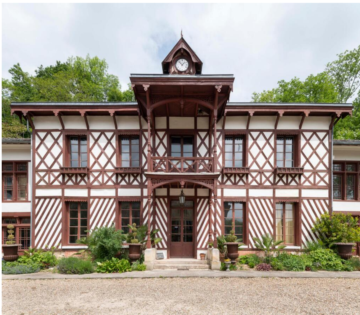
Bâtiment de la bibliothèque
