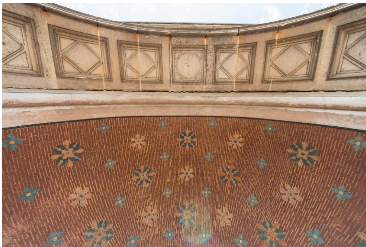
Détail du décor à l'intérieur de la loggia.
