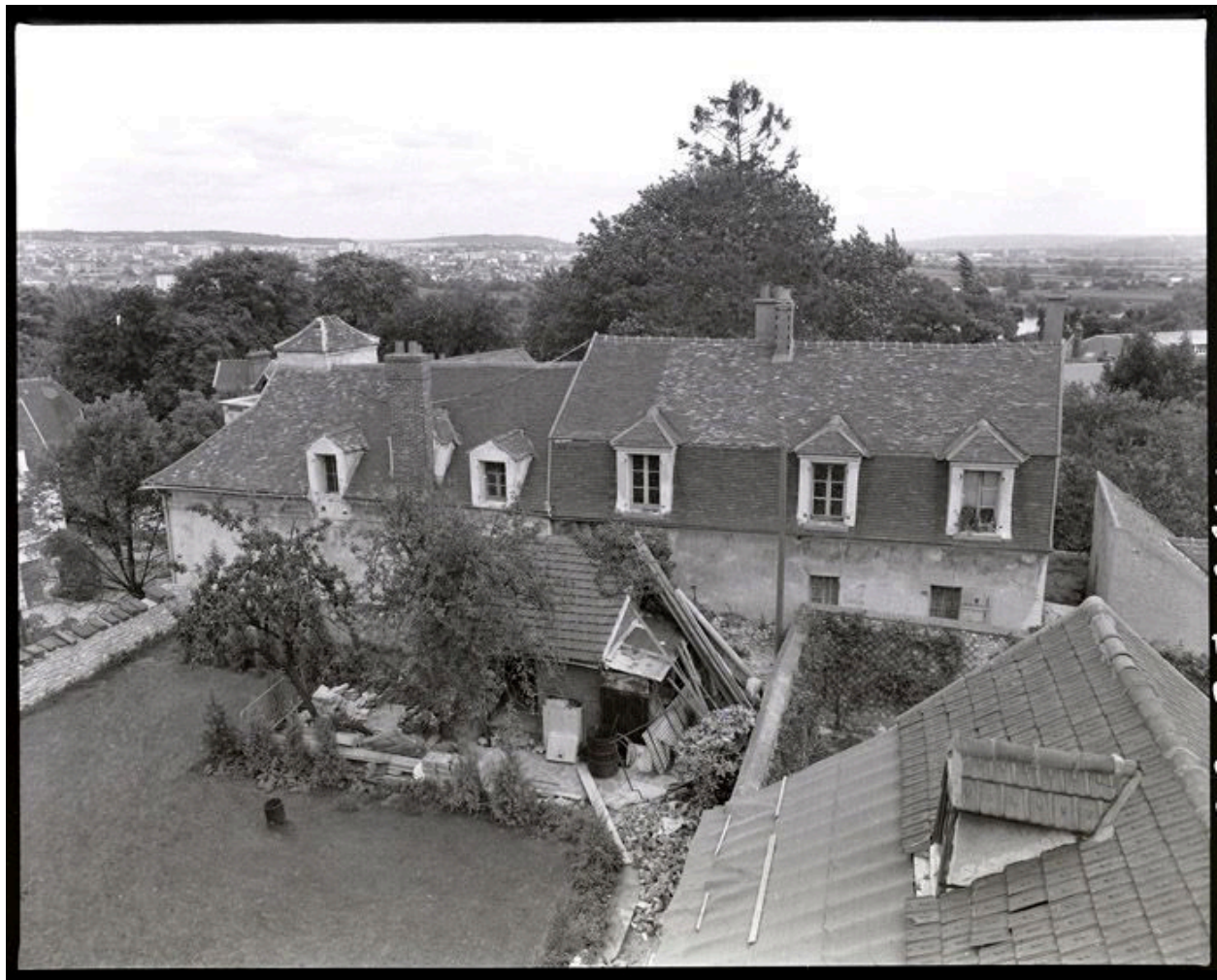
Maison, Abbé-Hua (rue de l') 10. Vue d'ensemble de la façade arrière.
