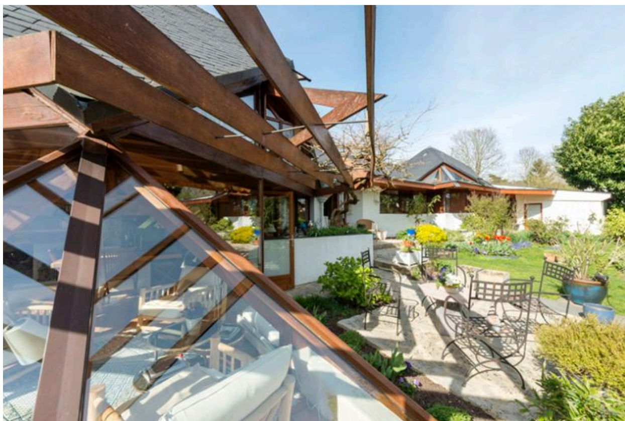
Vue latérale de la façade principale.
