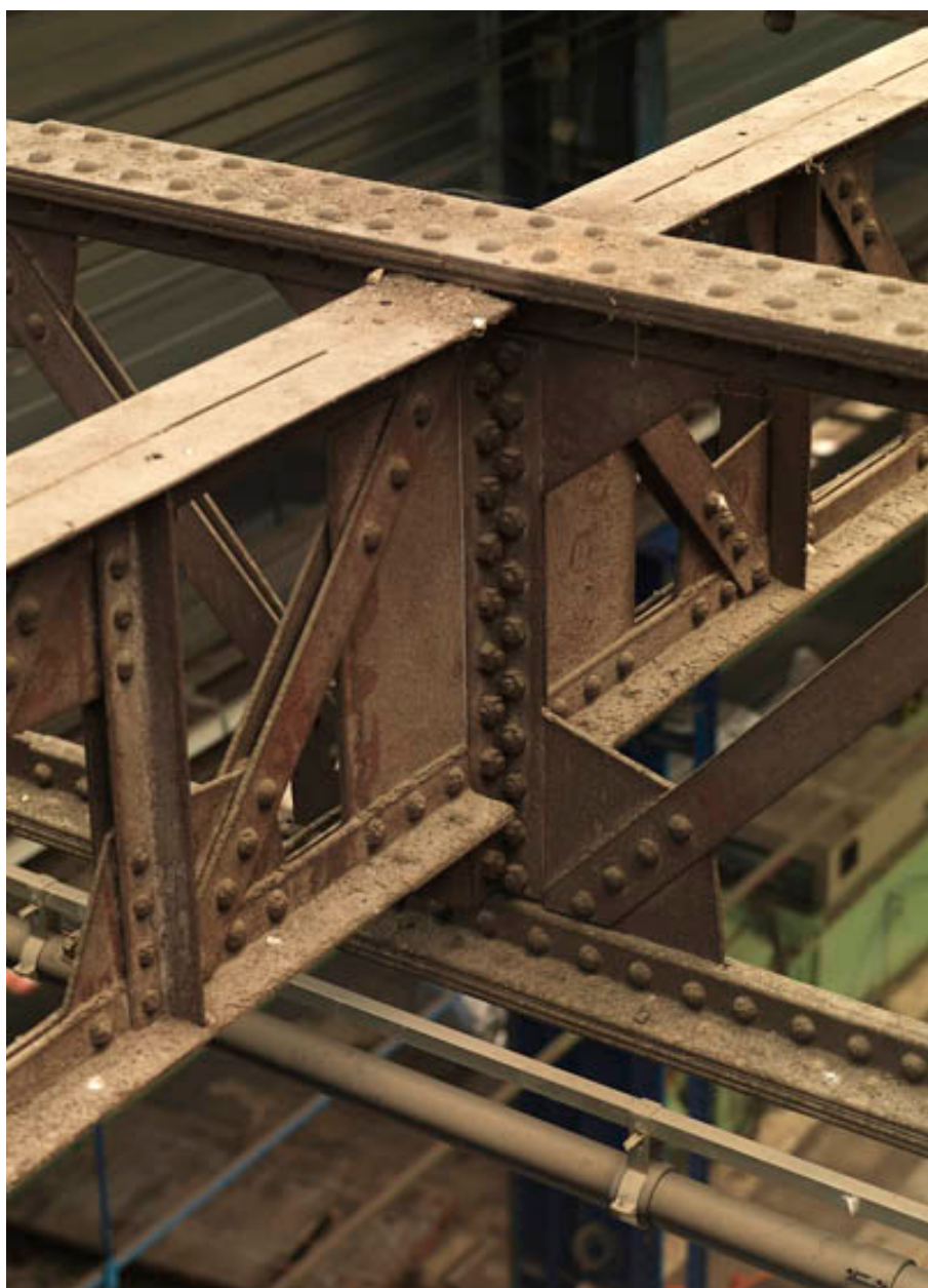
Vue intérieure de la nef centrale. Montage, machines-outils (1901-1903). Actuellement entreprise Jeumont Electric. Détail de la charpente métallique.
