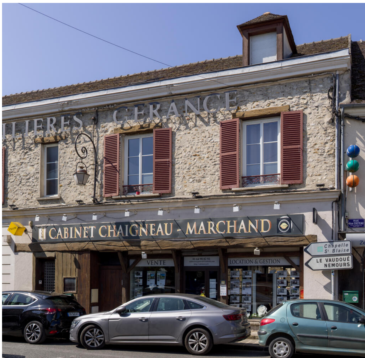
Partie ouest de la façade.
