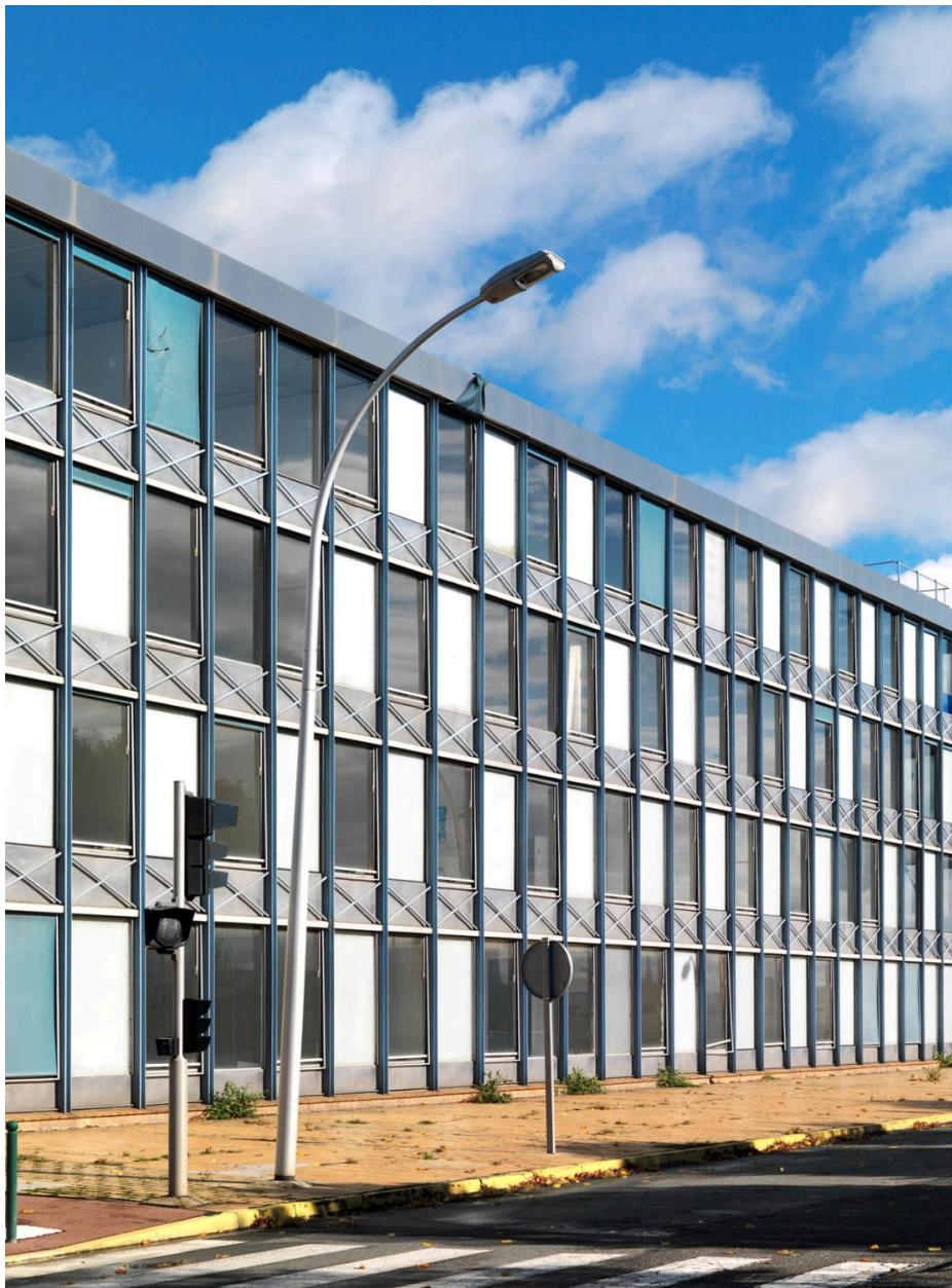
2012, le siège d'Air France ou bâtiment 363, détail de la façade sud vu depuis le sud ouest.
