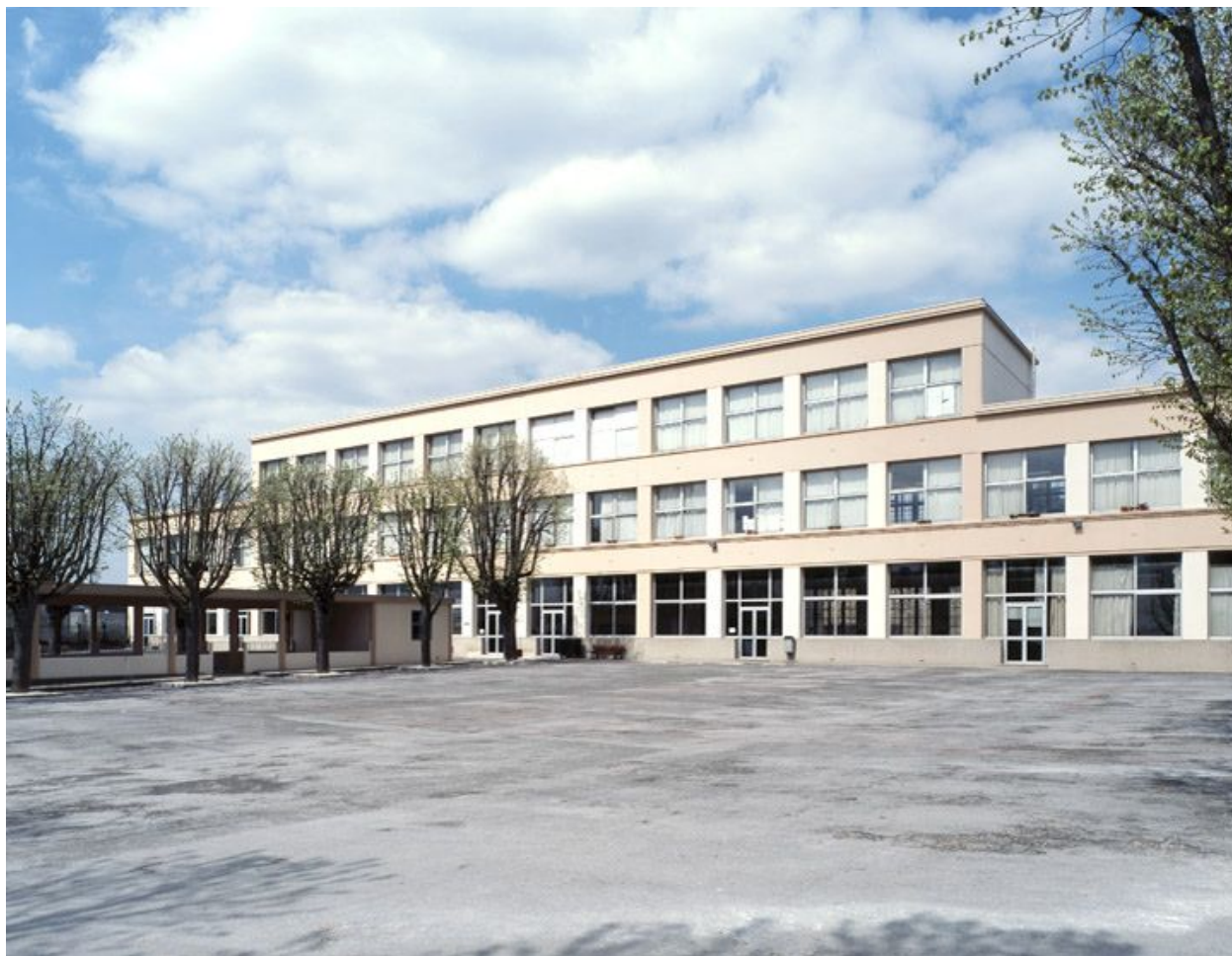
L'école primaire : la façade donnant sur la cour de récréation (élévation sud).
