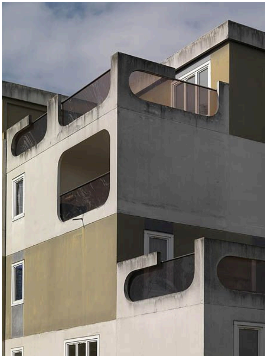
Détail des balcons et de la mise en oeuvre d'un immeuble HLM de Beauval B géré par l'Opievoy.
