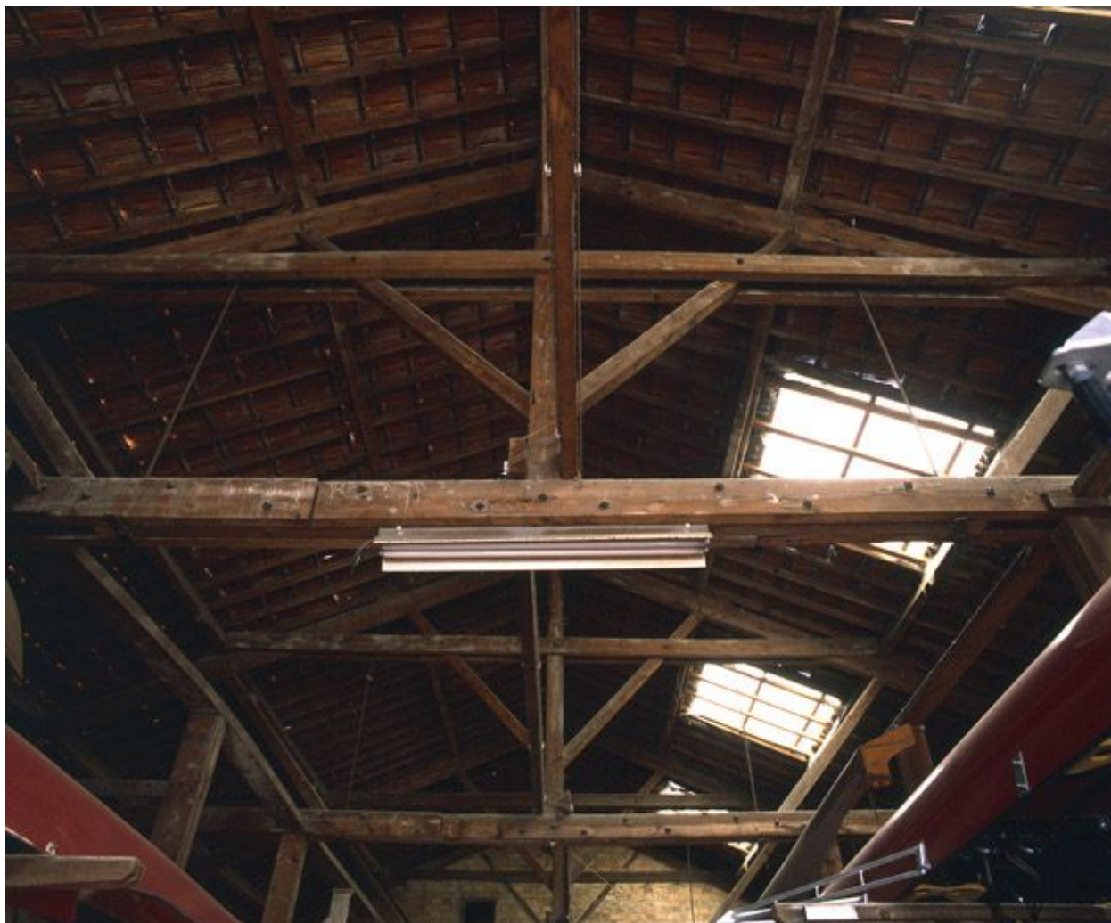
Vue intérieure de la charpente du 2e hangar à bateaux, montrant la structure à entrain et faux-entrain.
