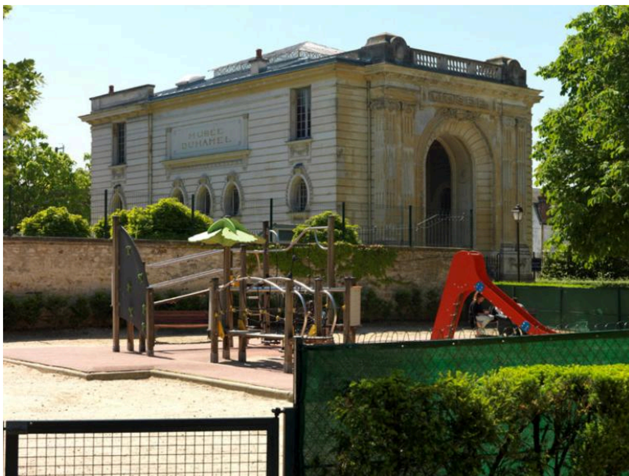
Vue de la façade latérale ouest.
