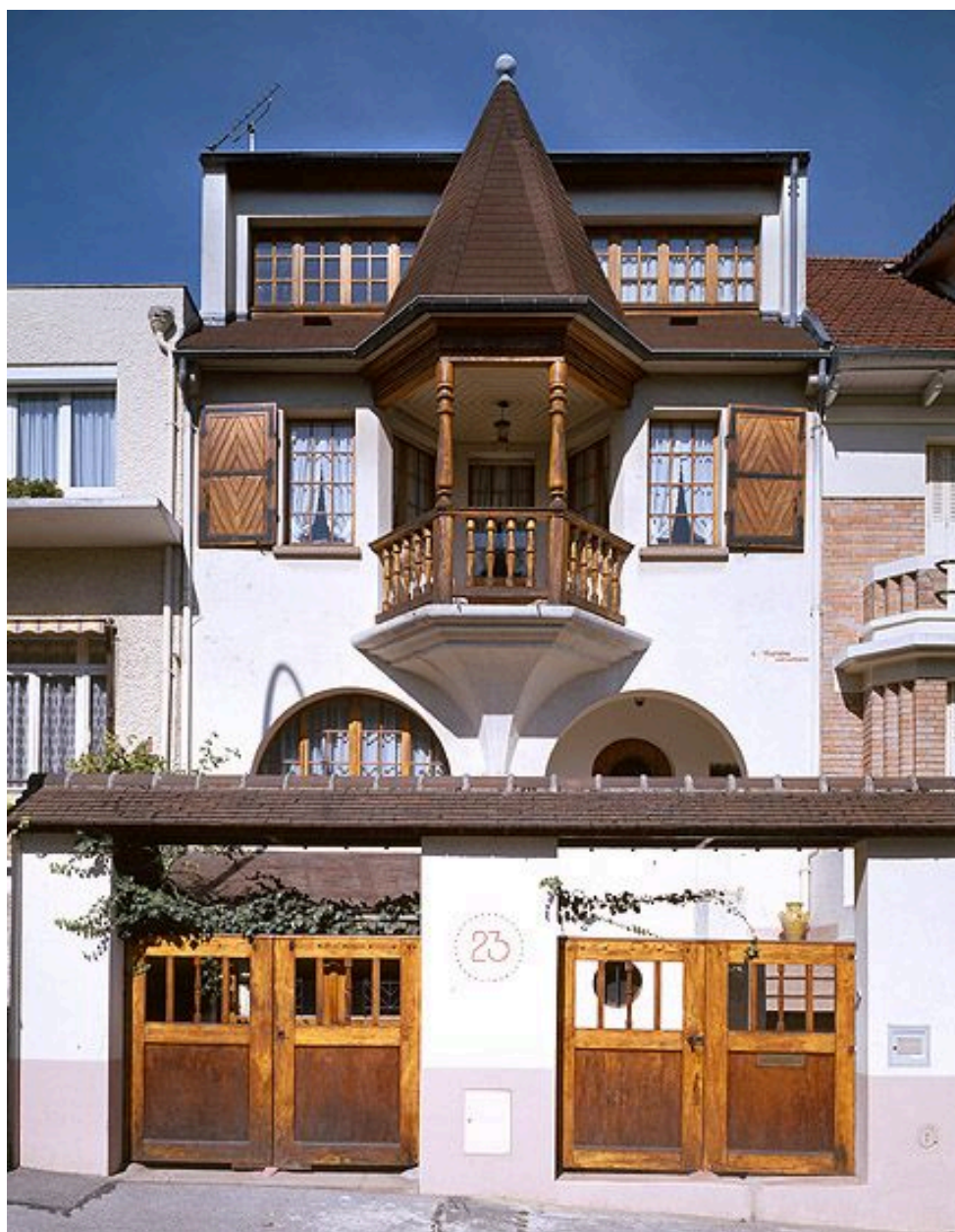
Maison, 23 rue Louis-Léon Lepoutre. Vue d'ensemble.
