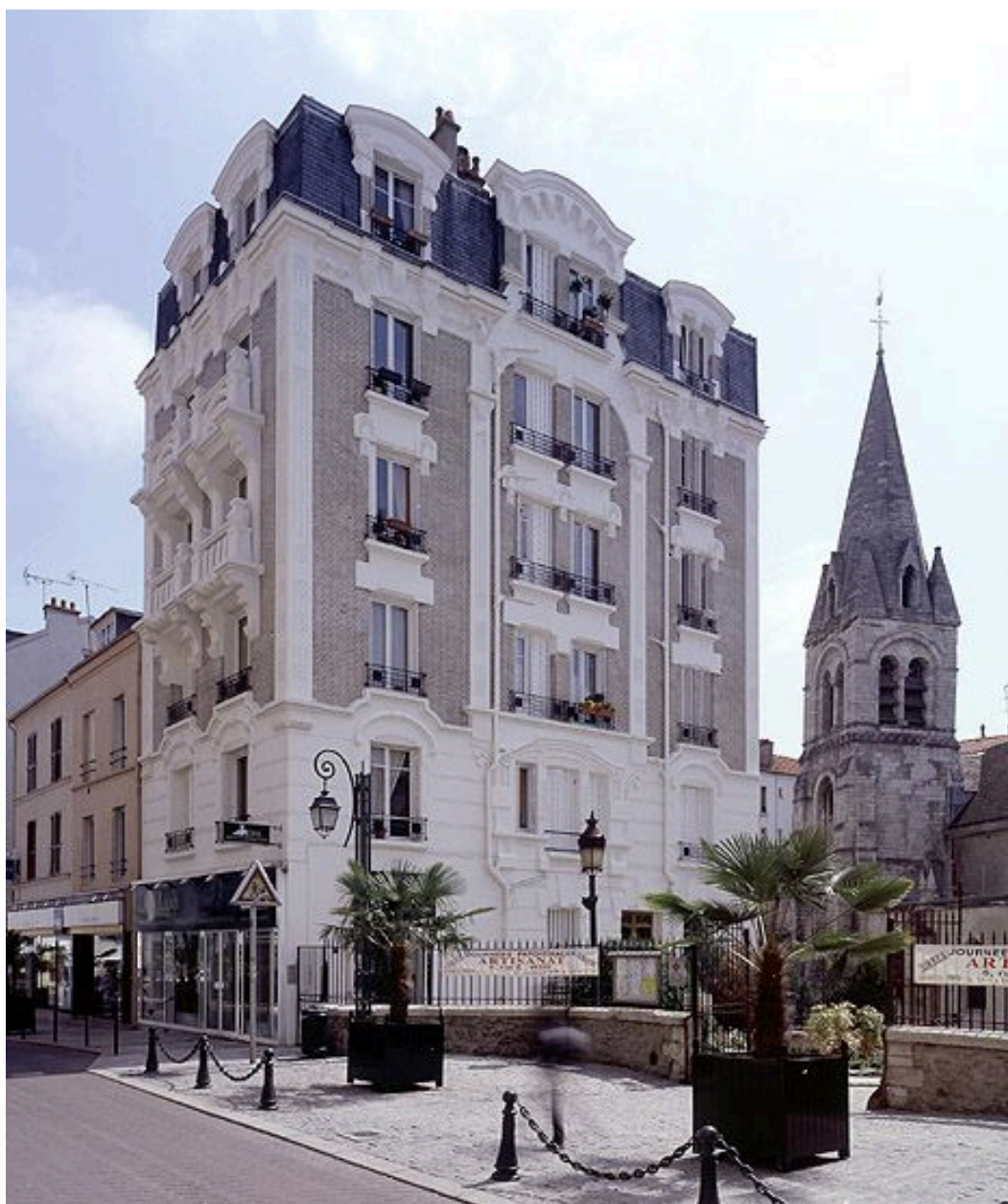
Immeuble, Grande rue charles de Gaulle. Vue d'ensemble.
