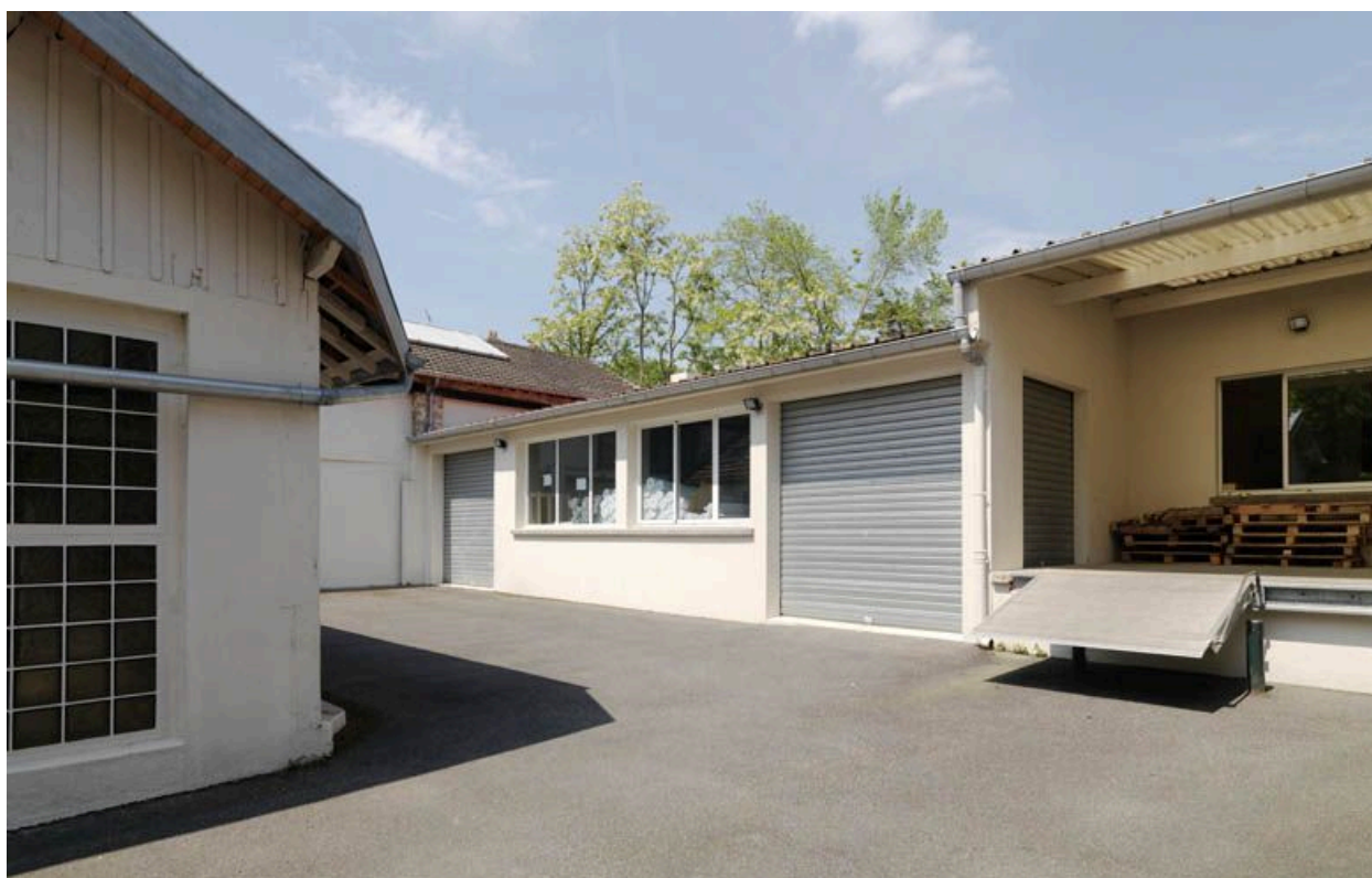
Vue générale depuis l'entrée du site.
