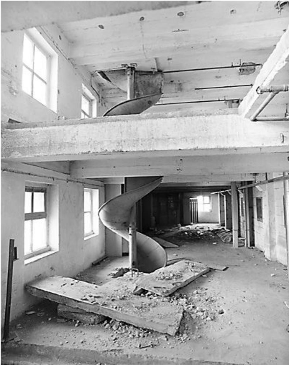
Partie magasin à farine. Au 2e étage, le tobogan hélicoïdal de manutention, utilisé pour l'acheminement de sacs de farine jusqu'au quai de chargement.
