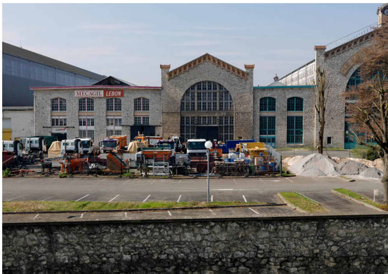
Vue extérieure de l'usine depuis la voie ferrée. Bâtiment de la liaison longitudinale sud.
