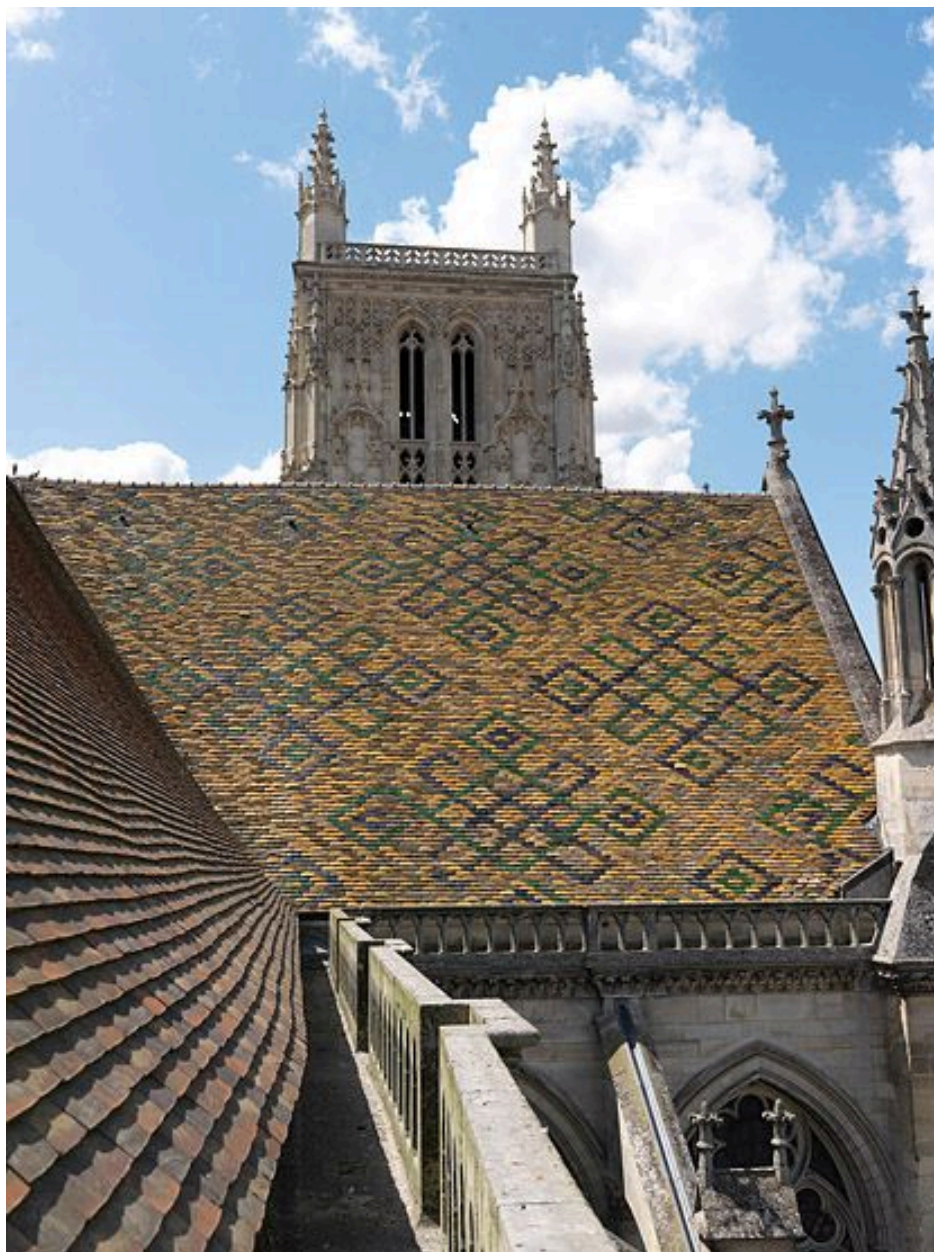
La toiture en tuiles polychromes du bras nord du transept, vue depuis la balustrade sommitale du choeur.
