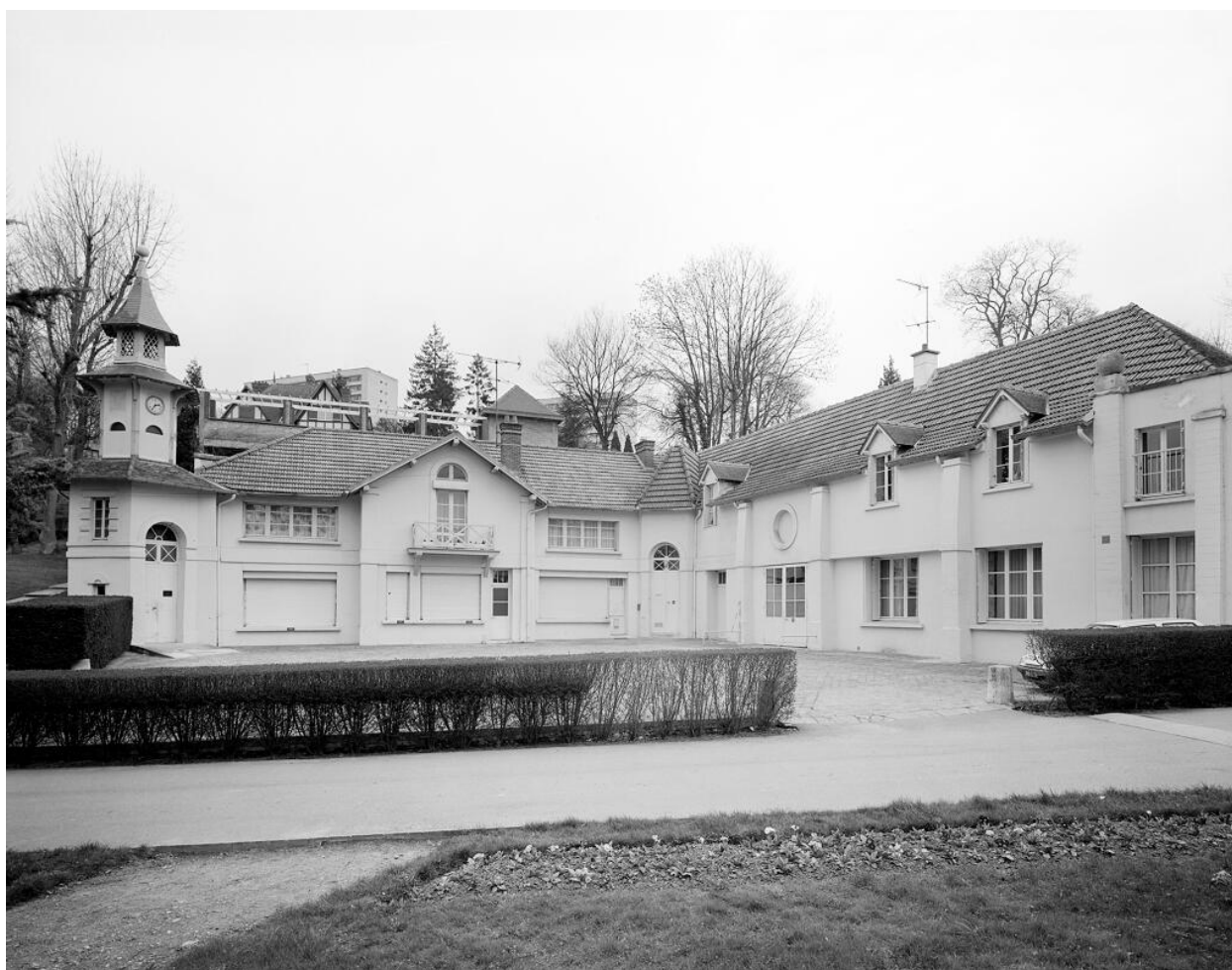
Vue des communs ; à gauche, aile avec le pigeonnier, début XXe siècle ; à droite, anciens communs remaniés.
