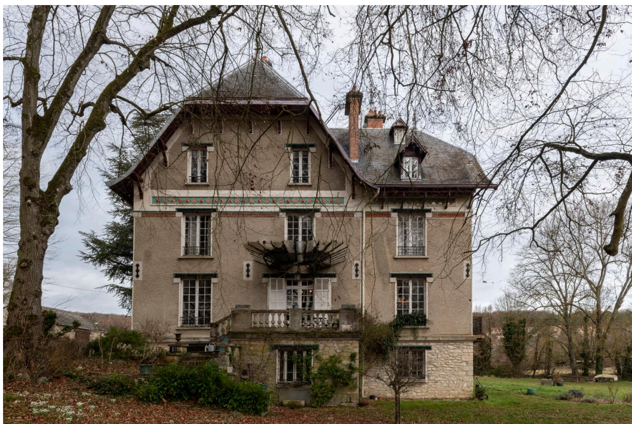
Façade sud-ouest, avec l'entrée
