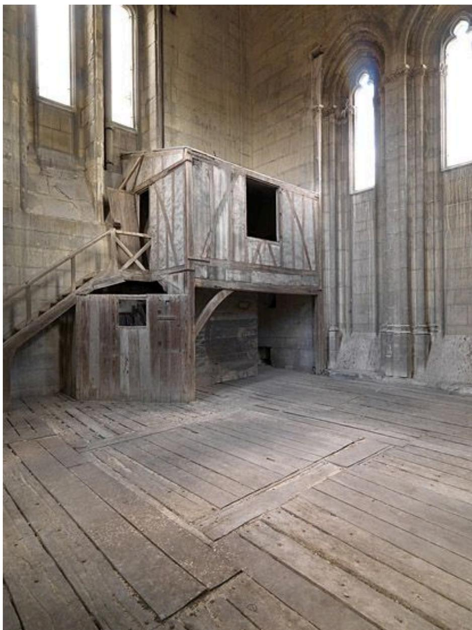
Tour nord, 2eme étage : vue intérieure, depuis l'angle nord-est. La construction en pan-de-bois abrite le mécanisme de l'horloge (voir cliché 20097701276NUC4A).
