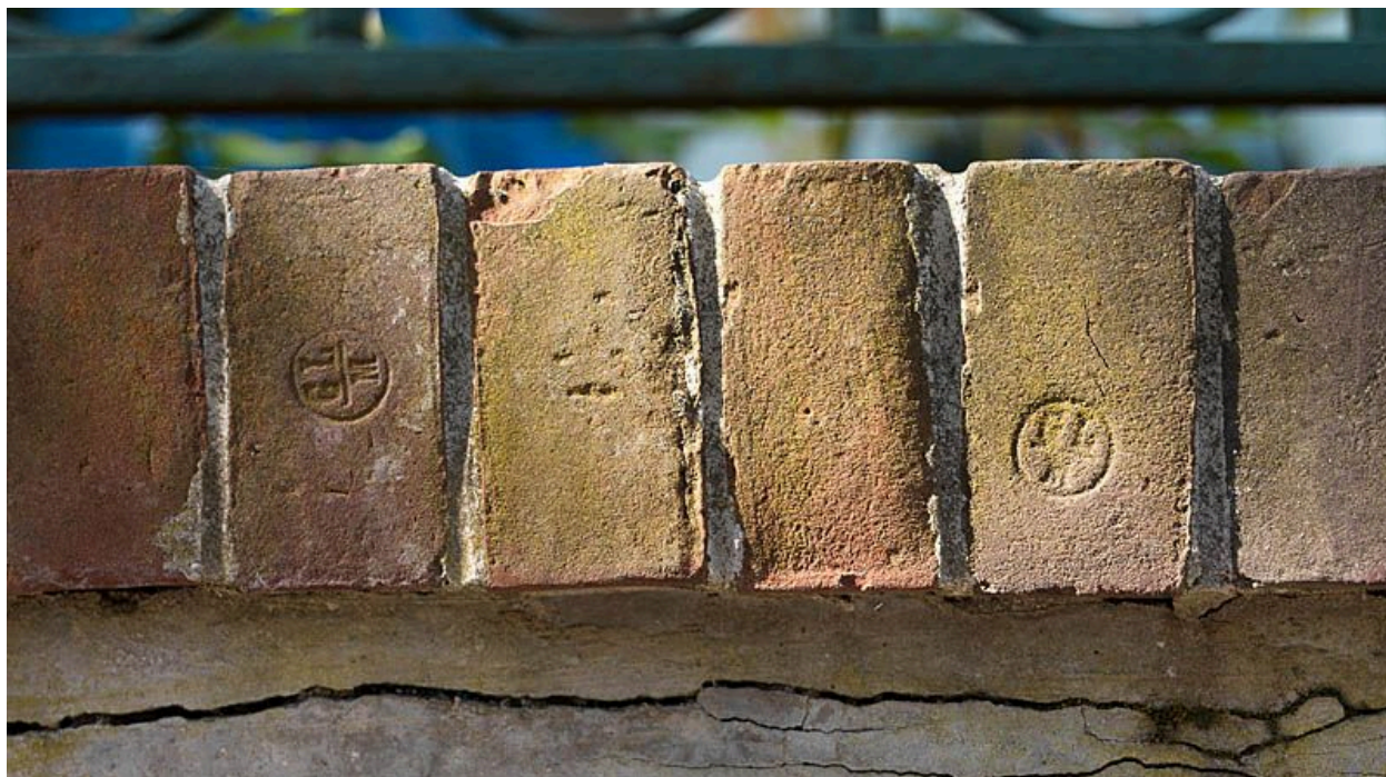
Détail du muret de clôture, au n°17 : briques marquées "GLM".
