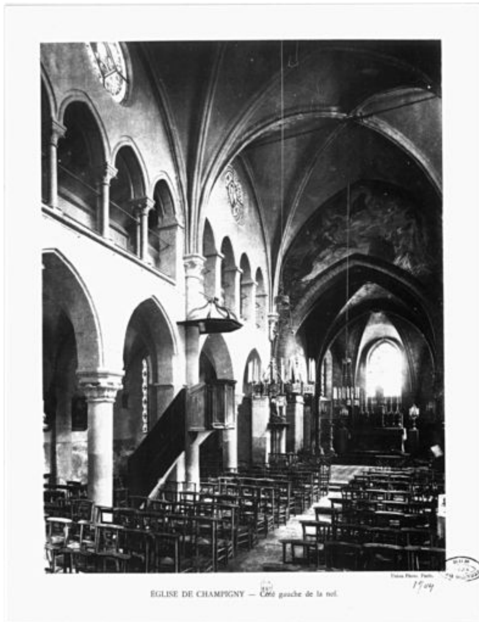
Vue de la nef et du collatéral nord en direction du coeur. Photographie, 1904. (BNF. Estampes, topo Va 94 fol., t.3, B 14250)
