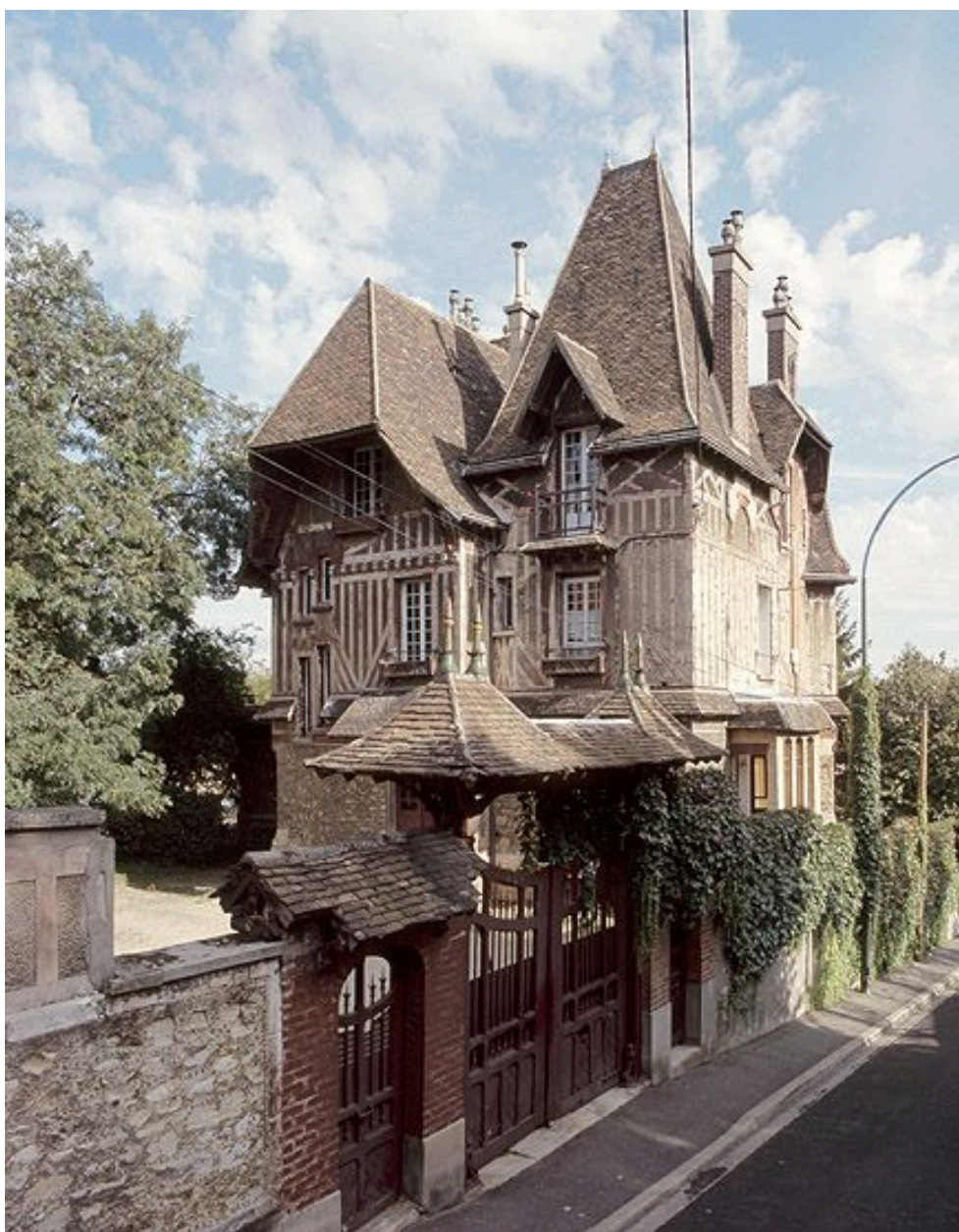
Maison, 19 rue Victor Basch. Vue d'ensemble depuis la rue.
