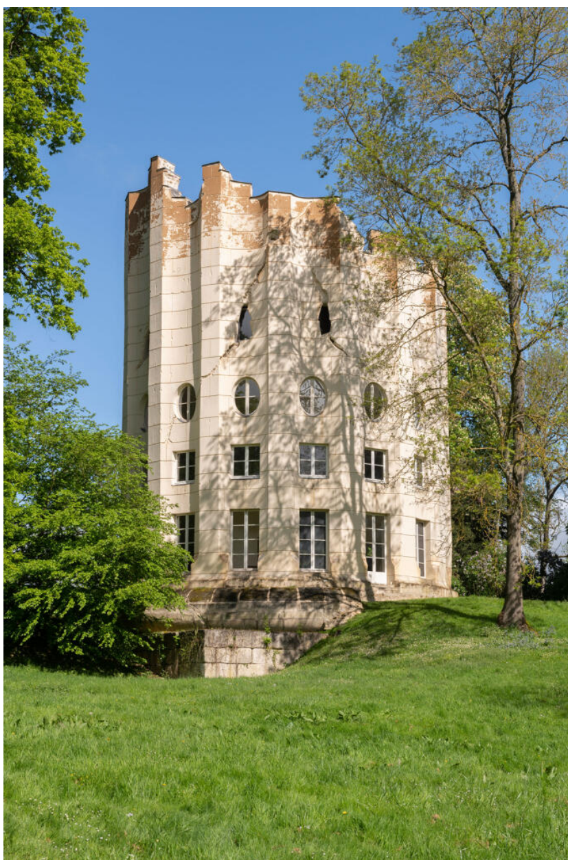
Vue générale du côté sud-ouest.
