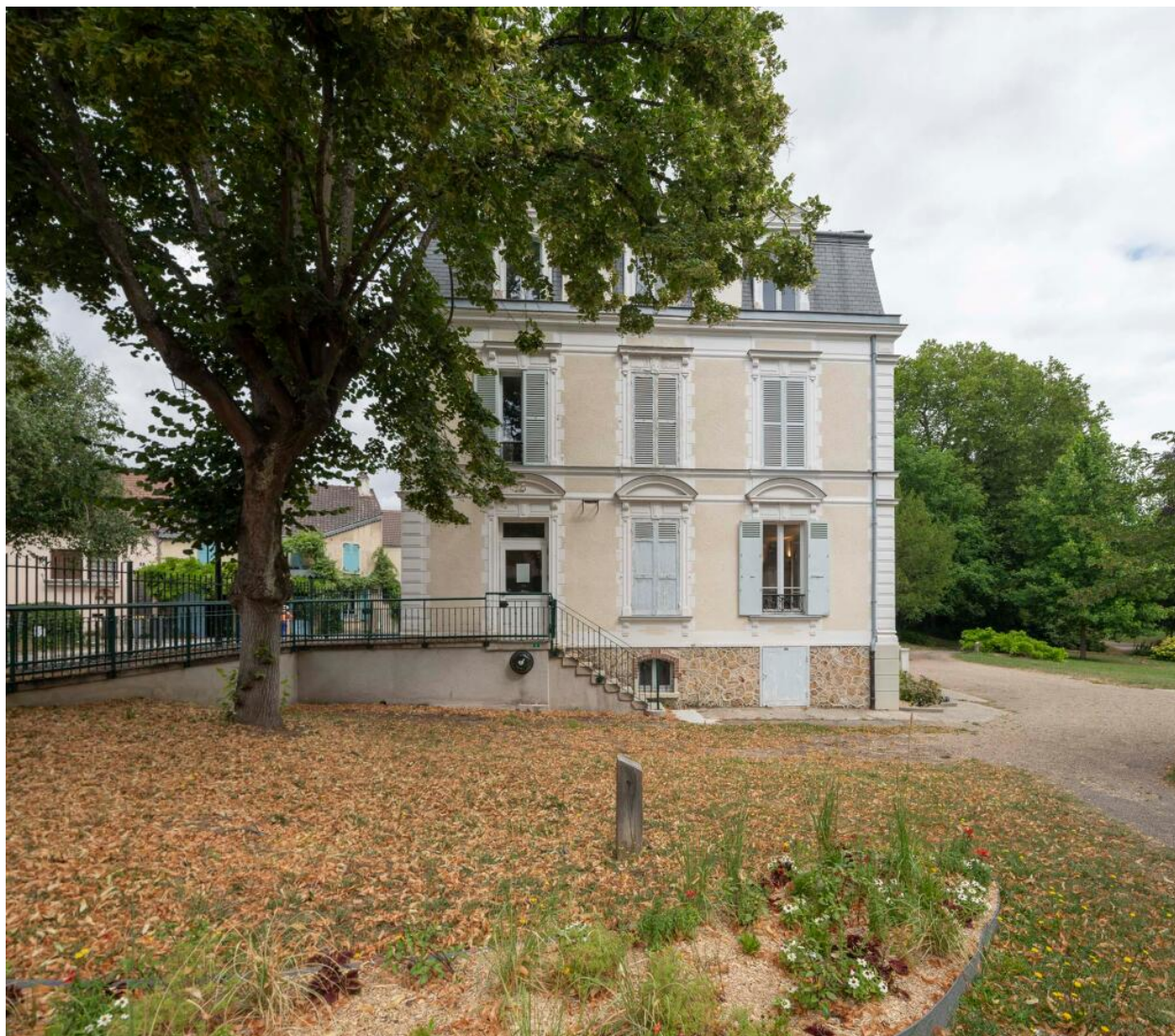
Façade latérale orientée sud-est.
