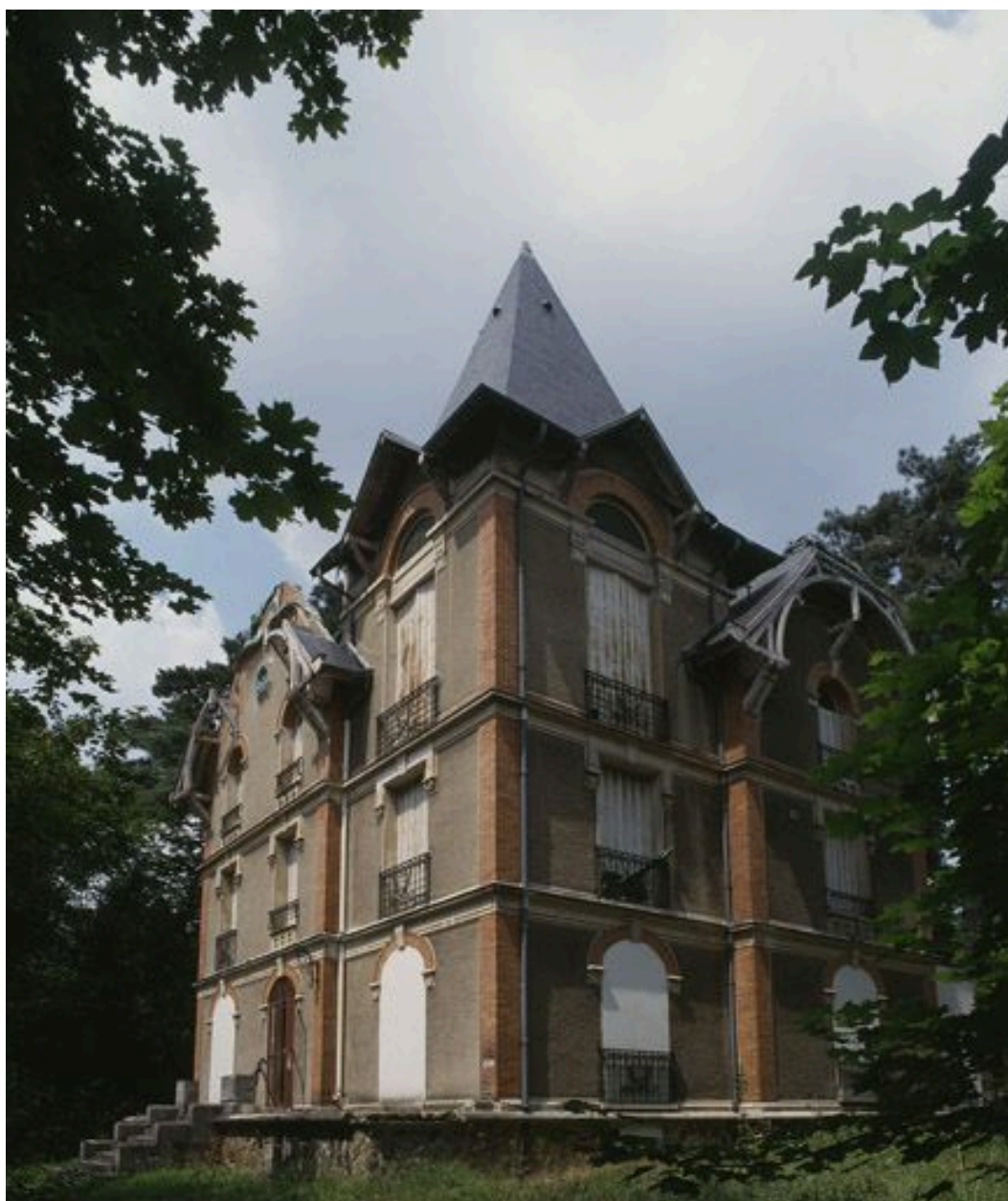
Façades antérieure et latérale.
