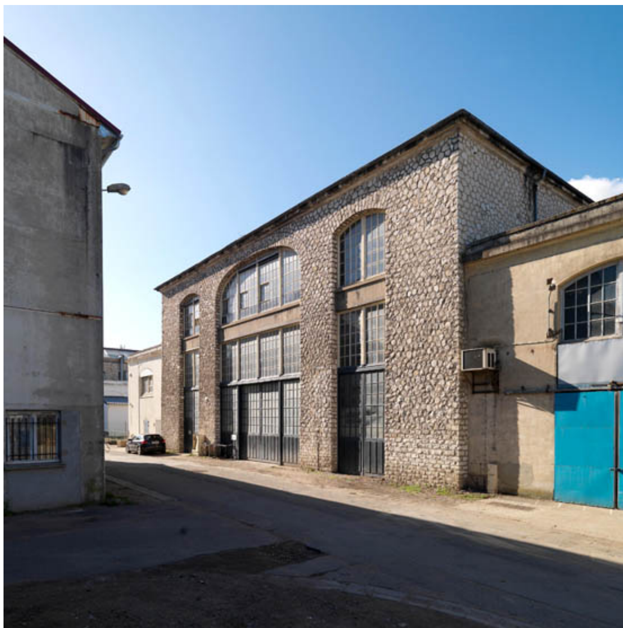
Extérieur du magasin générale (1915). Meulière blanche, la structure interne est en béton.
