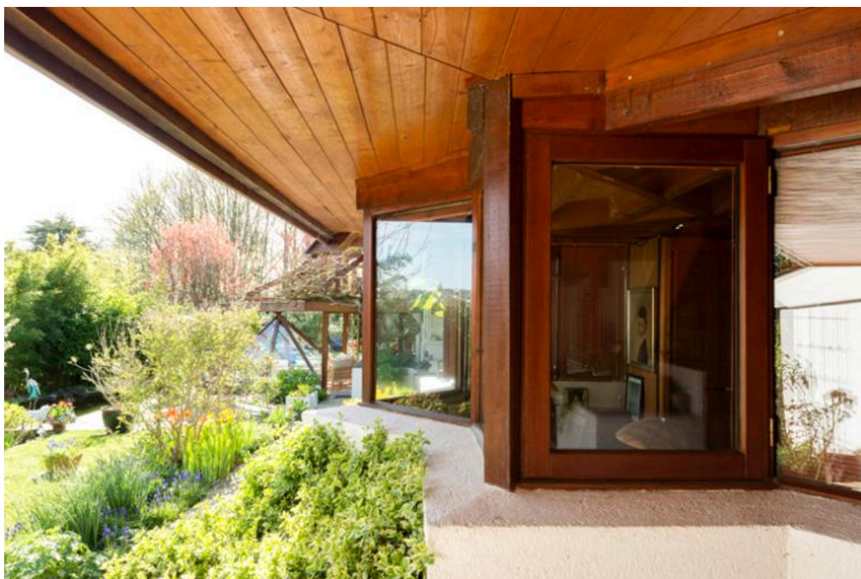
Vue de la façade principale : détail des baies et des lambris de la toiture débordante.
