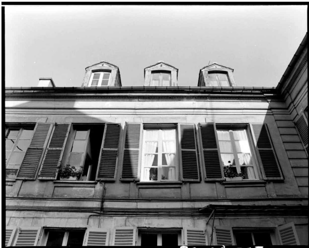
Maison, Gambetta (rue) 2. Façade sur cour.
