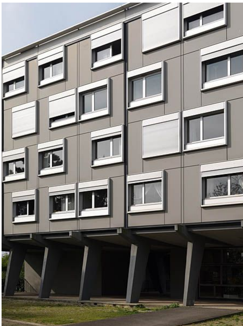
Façade et huisseries rénovées.
