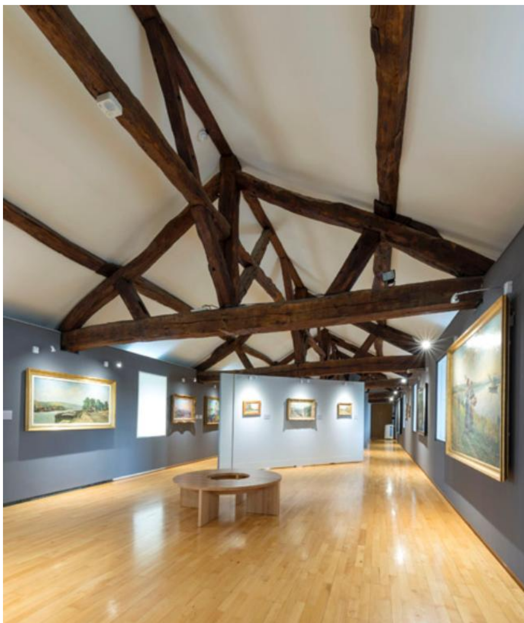
La charpente de l'ancienne chapelle.
