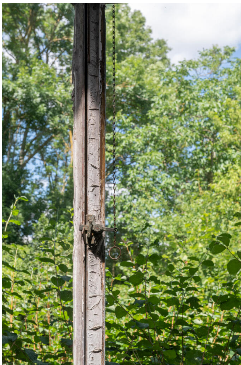
Détail d'une clenche sur la grande baie de l'atelier.
