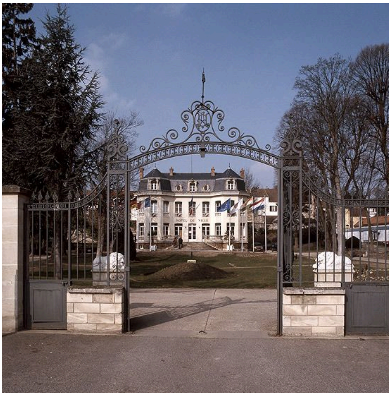
Vue d'ensemble depuis la Seine.
