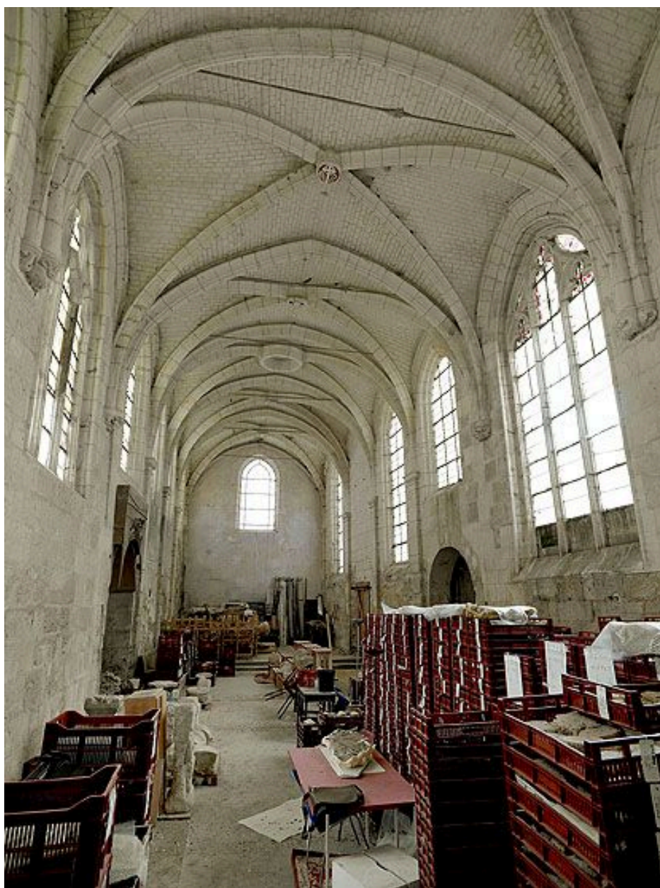
Vue intérieure générale, depuis l'est.
