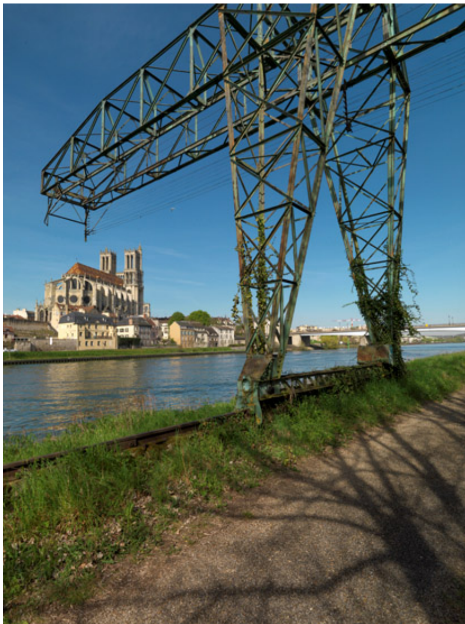
L'île aux dames : piles du pont transbordeur.
