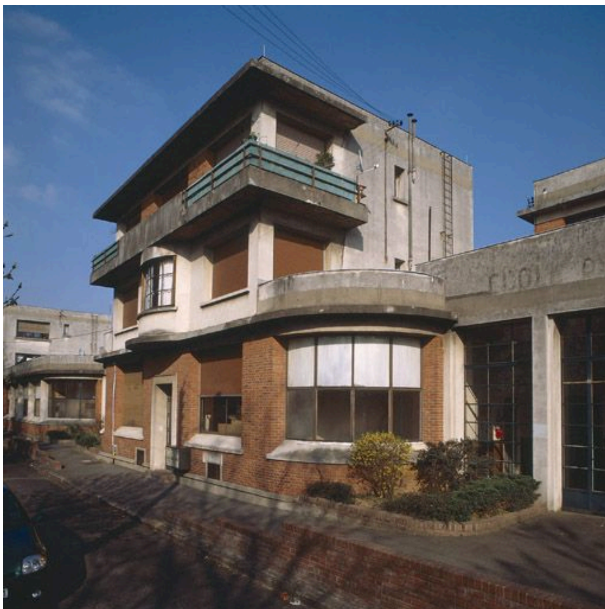
Le corps central du bâtiment abritant locaux administratifs et logements de fonction.
