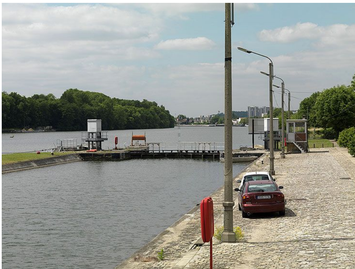
Ablon-sur-Seine, Vigneux. Barrage éclusé. L'écluse.
