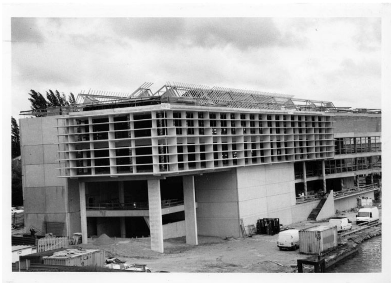
La médiathèque en cours de construction, 12 juin 2002. (Collection particulière)
