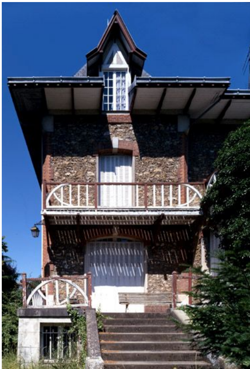
Villa donnant sur une impasse, rue du Général-de-Gaulle, face au collège Jacques-Amyot : vue du perron.
